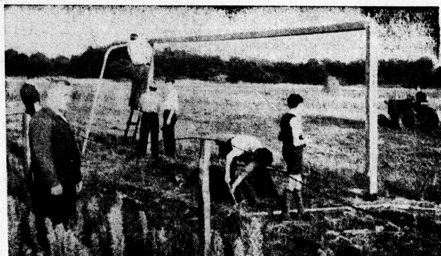
Die Gemeinschaftsarbeit macht den neuen Straberger Sportplatz doppelt wertvoll
