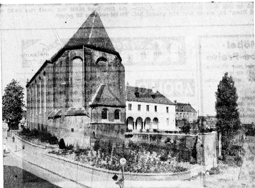
Das wiederhergestellte Zeughaus — Rückwärtige Gesamtansicht
