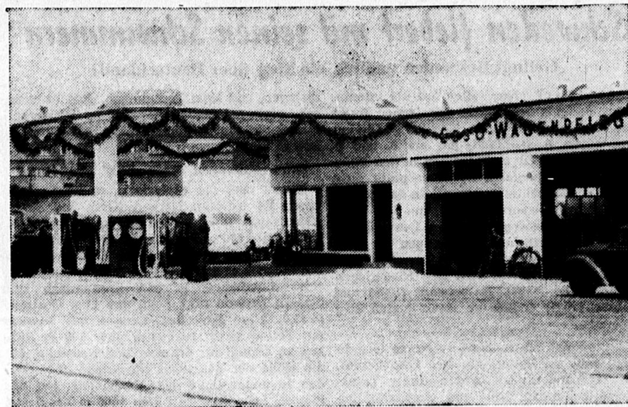
Ein Blickfang für Kraftfahrer ist die neue Esso-Großtankstelle
