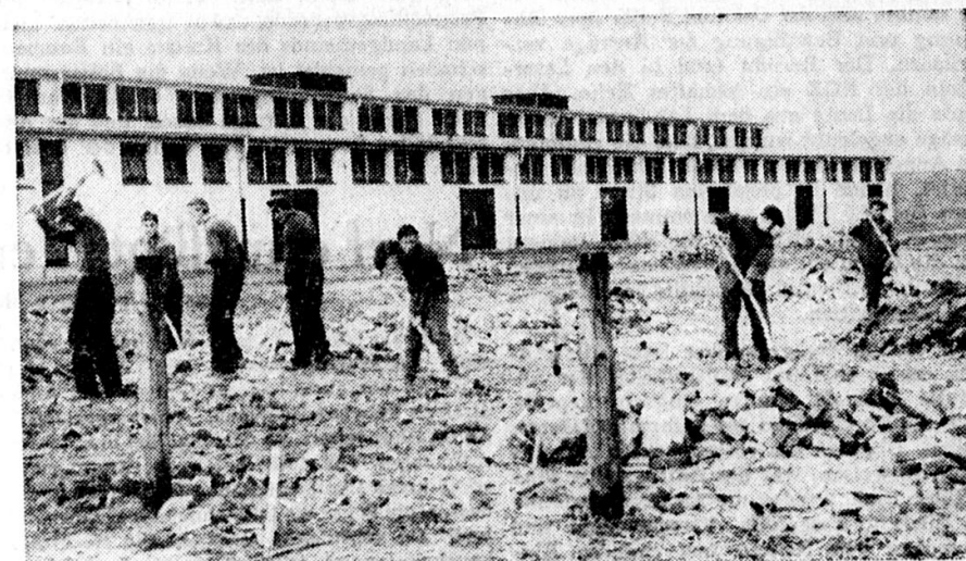
Die Befestigungsarbeiten auf dem Ausstellungsgelände gehen voran
