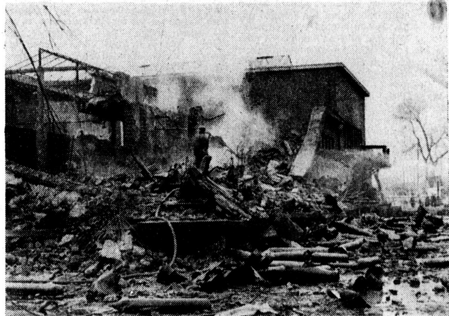
So sah es im Essener Acetylen-Werk aus, nachdem die Stichflammen eines plötzlichen Brandes 2500 Stahlflaschen mit Acetylen zur Explosion gebracht hatten. Nach Augenzeugenberichten dachten viele Essener, die erste Atombombe sei gefallen, als sie von der gewaltigen Explosion aus dem Schlaf geschreckt wurden. Entgegen sofort umlaufenden wilden Gerüchten wurde jedoch nur ein Arbeiter tödlich verletzt — tragisch genug, da er sich als einziger zu Löscharbeiten herange-wagt hatte.
