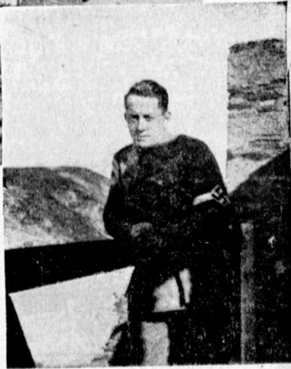
Oberbannführer Conrad auf der Baustelle der Jugendburg Stahlede
