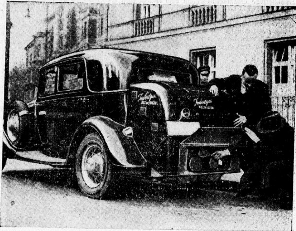
Holz statt Benzin Ein normaler Ford mit Imbert-Generator, der die Alpenfahrt siegreich überstand
