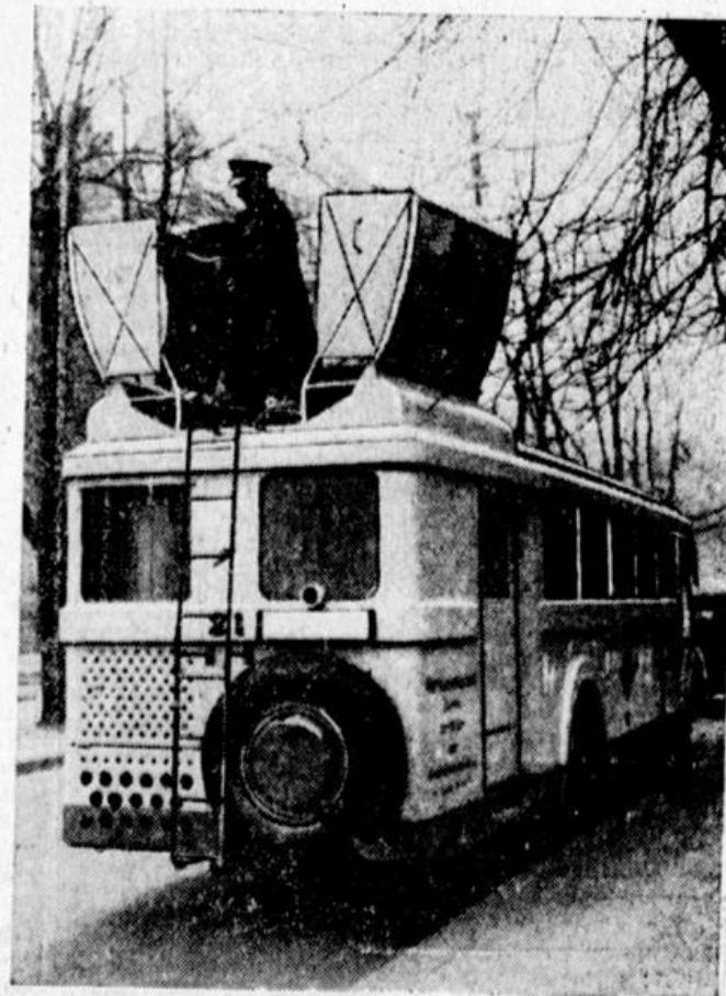
„Tanke im Walde“ Ein Omnibus, der mit deutschem Abfallholz angetrieben wird
