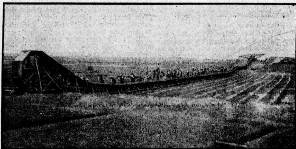
Deichbau am laufenden Band. Bei den Arbeiten zur Neulandgewinnung an der holsteinischen Westküste werden erstmalig große Förderbänder zum Deichbau verwendet. Der aus dem Vorland entnommene Boden wird auf den Plattenförderer geschaukelt und an der Verwendungsstelle durch Verteiler nach beiden Seiten abgeworfen. Die Bänder besitzen eine Förderlänge von 200 Metern, ihre Stundenleistung beträgt 150 Kubikmeter.
