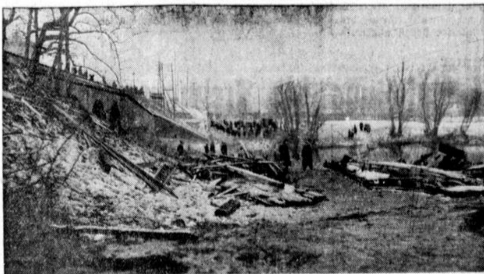
Trümmer, die durch die Wucht des Zusammenstoßes von der Saalebrücke hinabgeschleudert wurden. Das entsetzliche Unglück bei Großheringen am Weihnachts-Feiertag hat 32 Tote gefordert.
