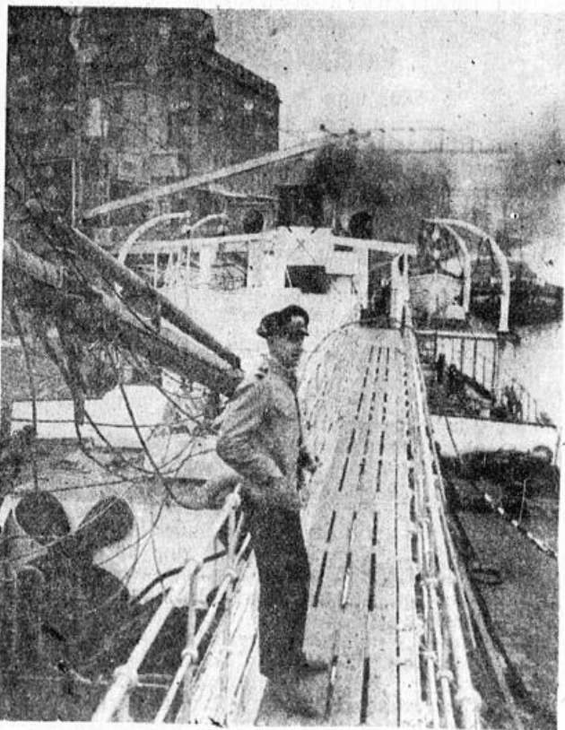
Ein Blick von der Kommandobrücke
