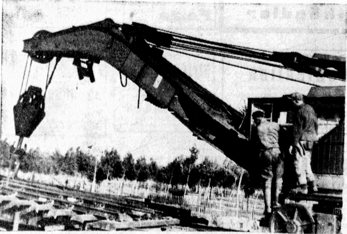
Der Kran mit dem senkbaren Ausleger hebt eine halbe Weiche
