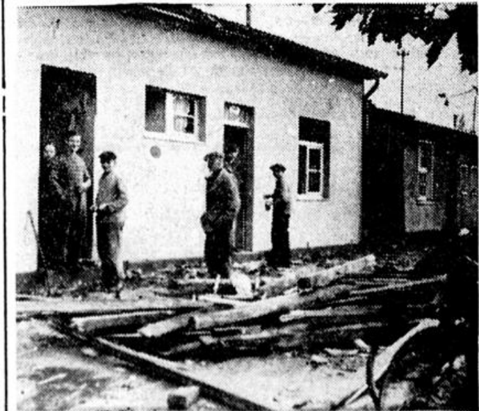
60 Meter weit wurden Wälle weggeschleudert. Foto: Pfeifer, Neuß.
