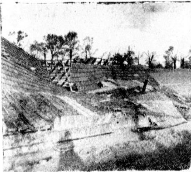
Der eingedrückte Kiegleisshuppen, im Hintergrund ein Teil der zerstörten Pappeln des Scheibendamms.
