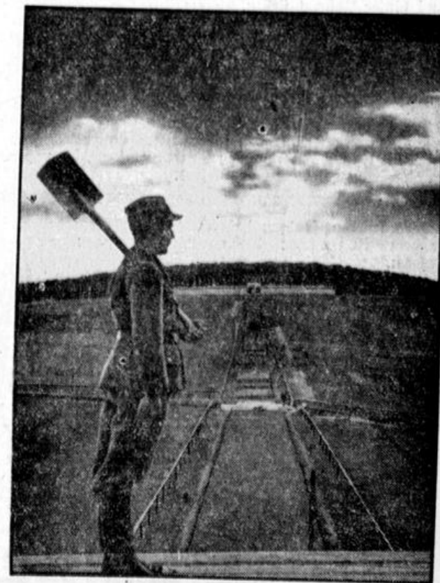
Der Büdberg ist gerüstet
