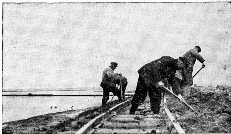
Die leeren Lören rollen zurück, die Erde wird ausgebreitet, ein Damm entsteht.
