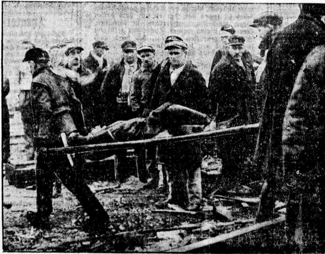
Abtransport der Opfer einer der schwersten Katastrophen, die die Geschichte des Eisenbahnwesens zu verzeichnen hat.
