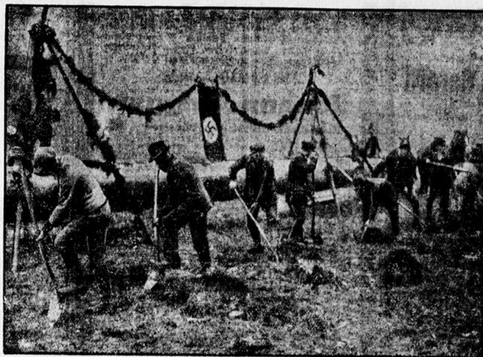
Die ersten Spatenstiche werden getan.
