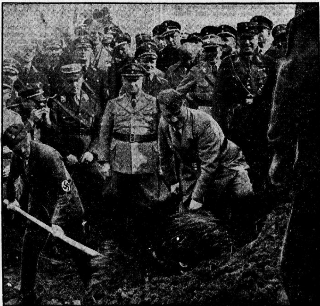
Den ersten 700 Arbeitern werden in Frankfurt a. M. die neuen Werkzeuge für den Straßenbau übergeben.
