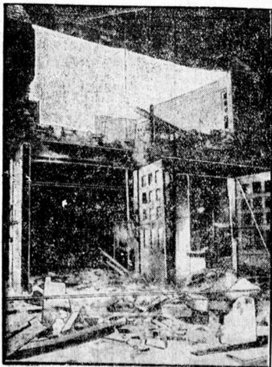
Ein zerstörtes Geschäftshaus in Compton (Kalifornien), wo das Erdbeben besonders furchtbare Zerstörungen anrichtete.
