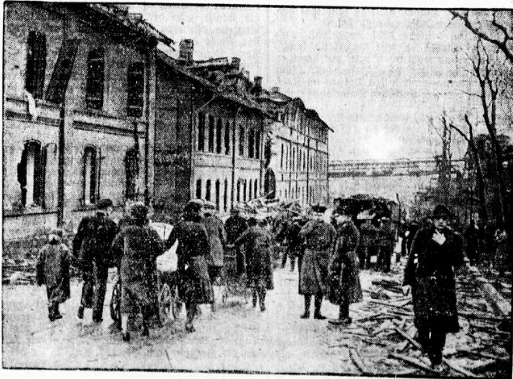
Eine Straße in Neunkirchen: Kein Haus ist mehr bewohnbar.
