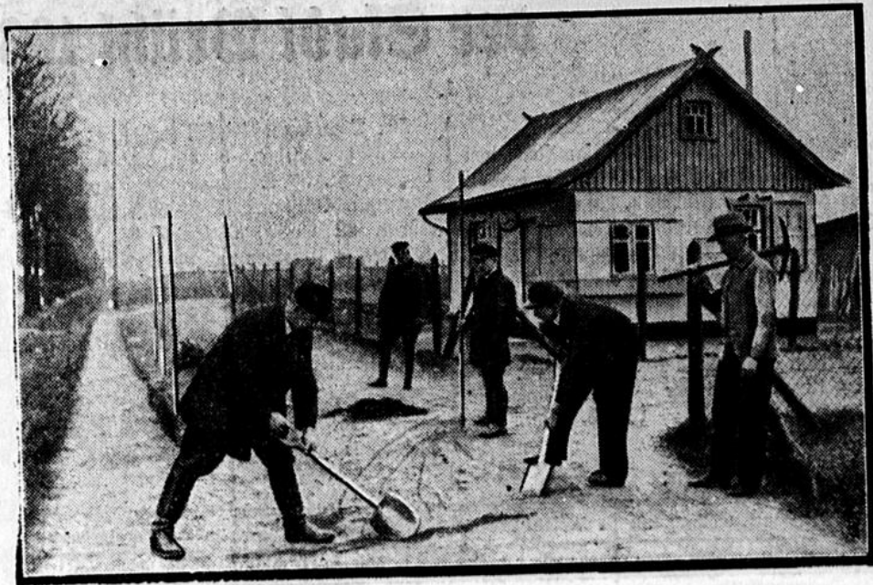
Der erste Spatenstich für Berlins Erwerbslosensiedlung
