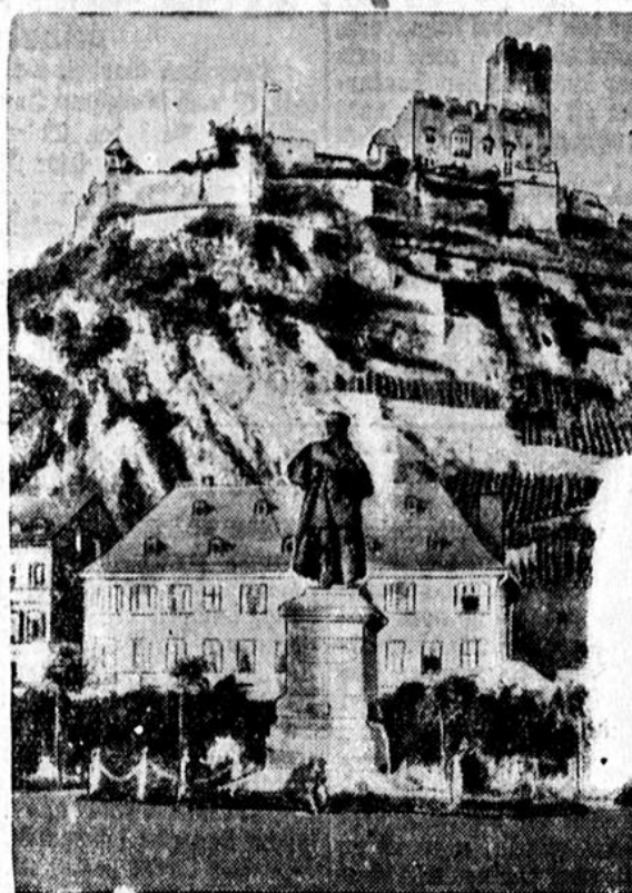
Caub von schwerem Bergsturz bedroht.
