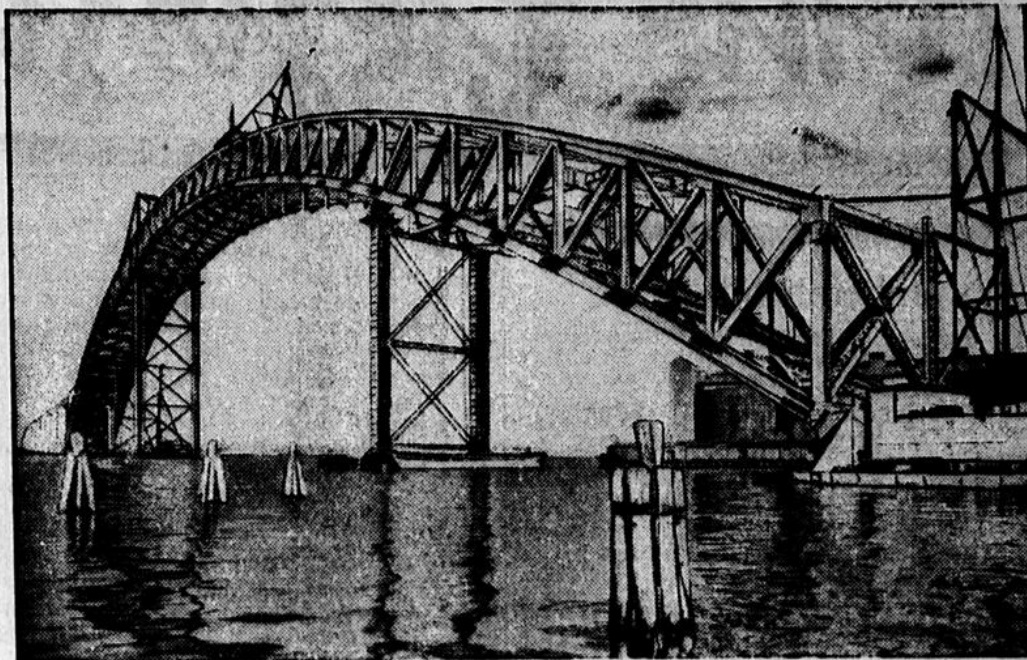
Die größte Bogenbrücke der Welt.
