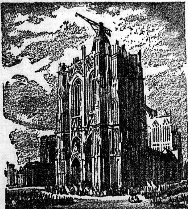
Das Turmfragment vor Beginn des Ausbaues.
