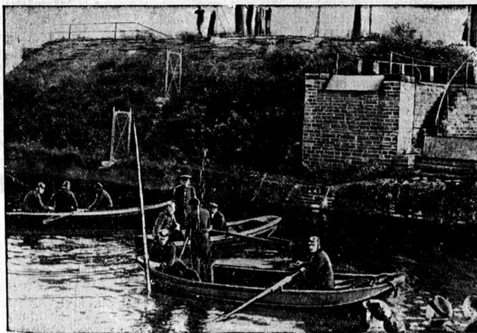
Die Vergungsarbeiten in Koblenz
