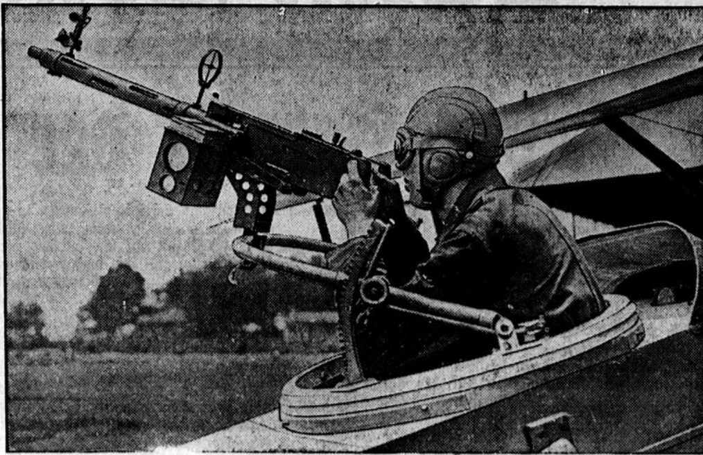
Wieder und wieder: Fortschritte der Kriegstechnik. Das neueste und gefährlichste Maschinengewehr, das auf Kampfflugzeuge aufmontiert wird, vermag in der Minute 6-800 Schüsse zu feuern.
