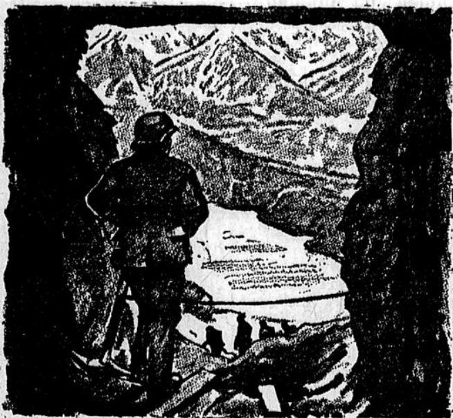
Durchblick von „Fenster 4“ auf den Eibsee. Zum Schutz gegen Steinschlag mußten Arbeiter und Ingenieure mit Stahlhelmen ausgerüstet werden.
