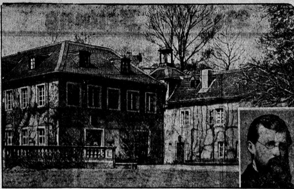
Das Jacobshaus des Düsseldorfer „Malkastens“ unter Denkmalschutz
