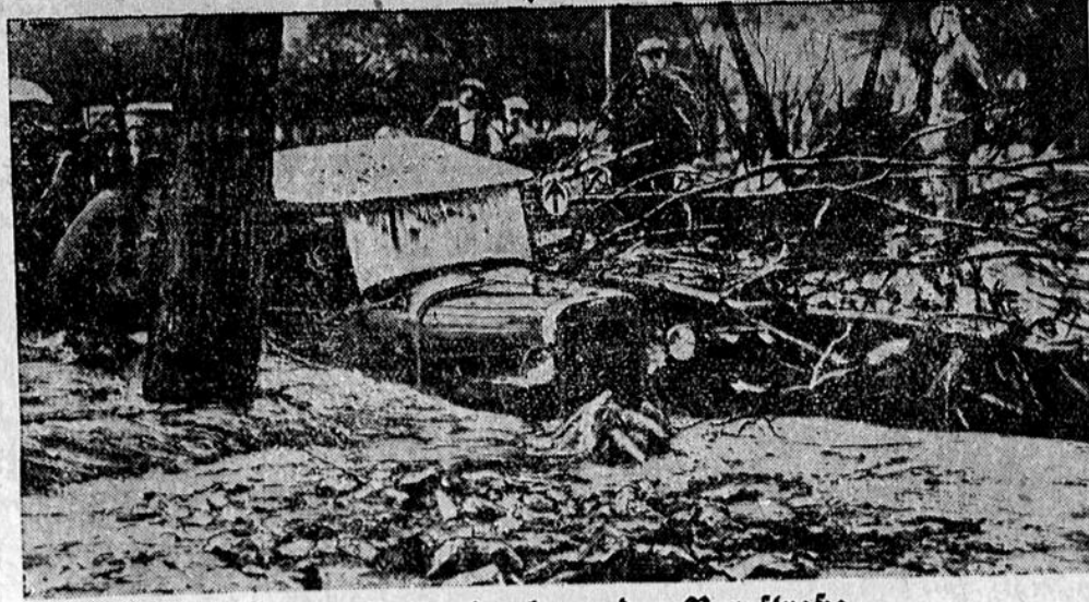
Der Wolkenbruch an der Bergstraße
