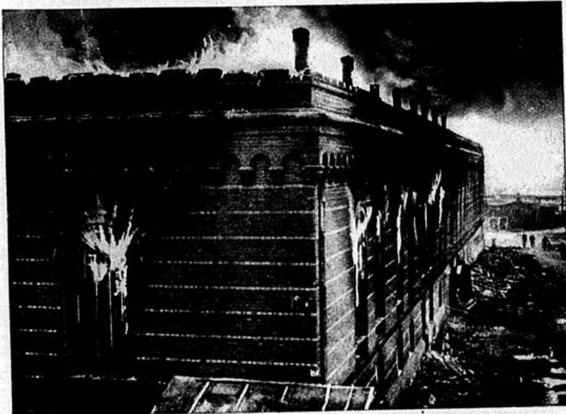
Großfeuer in der Magdeburger Zitadelle. Die gesamte Feuerwehr der Stadt konnte des Feuers kaum Herr werden. Der Brand entstand durch Explosion von Benzinfässern im ehemaligen Gewehrhaus (Bild oben), das kurz darauf einstürzte Sennede
