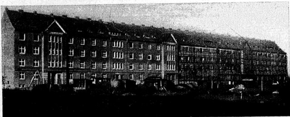
Moderne Hochhäuser in Hannover, die 96 freundliche, hygienisch einwandfreie Zweizimmerwohnungen enthalten
