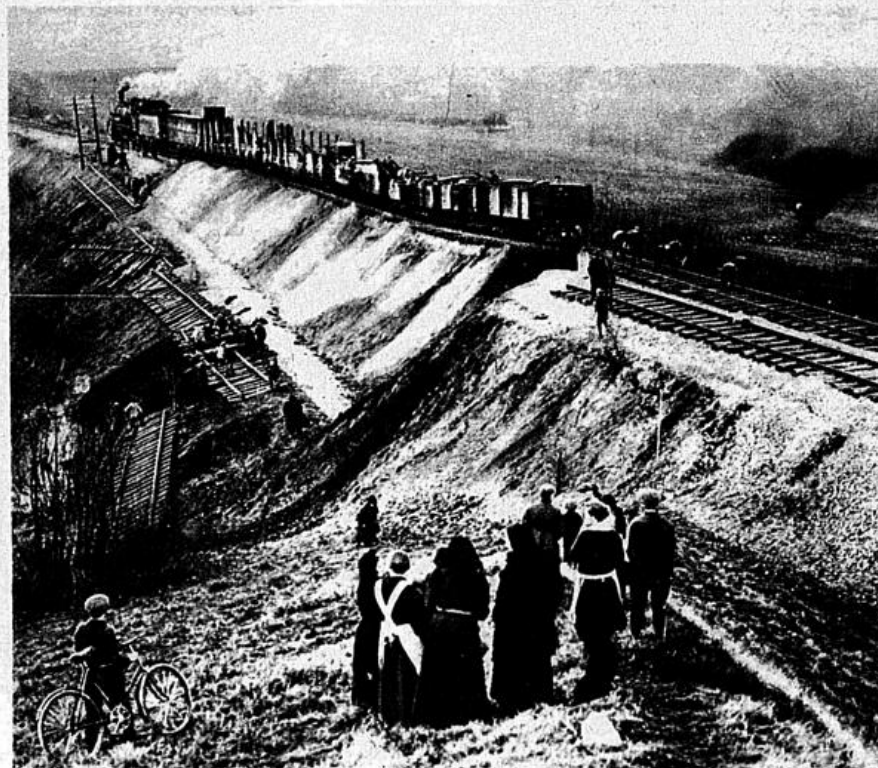
Ein großer Dammrutsch an der Strecke Neubrandenburg—Stettin verursachte eine längere Unterbrechung des Eisenbahnverkehrs. Auf einer Strecke von etwa 80 Metern ist die eine Hälfte des Bahndamms mit dem Gestein einfach weggesackt. Sennede
