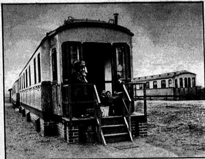
Auch in Provinzstädten herrscht Wohnungsnot. Die Stadt Wittenberg hat eine Anzahl Familien in D-Zug-Wagen untergebracht Bild links: Die engen, schachtförmigen Hinterhöfe lassen kaum Sonne und frische Luft in die unteren Wohnungen
