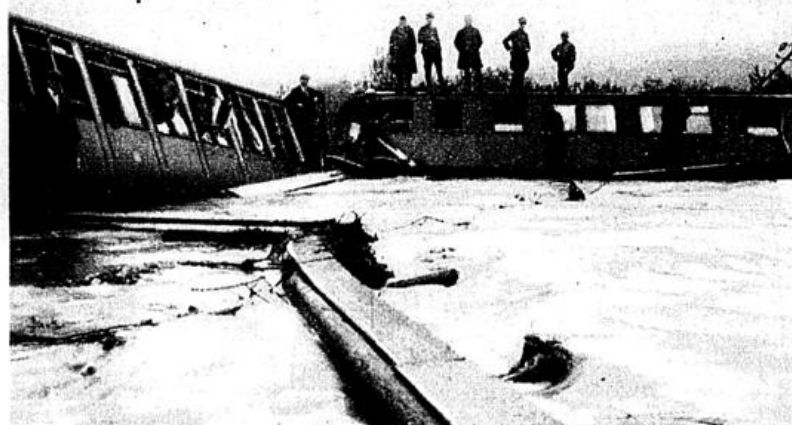
Neuschnee und Südwinde verursachten große Überschwemmungen in Südtirol. Die Eisenbahnlinie Bozen—Meran wurde vom Hochwasser der Etsch auf einer Strecke von 100 m unterspült, so daß der Fröhzug in der Dunkelheit abstürzte. Lokomotivführer und Heizer ertranken. Atlantic
