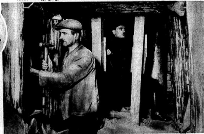
Vom Umbau des staatlichen Opernhauses in der Reichshauptstadt. — Ein Hauptteil der äußerst schwierigen Bauarbeiten besteht in der Anlage einer Versenkung für die Bühne in 16 m Tiefe. — Rechts: Mächtige Versteifungen an den Außenwänden während der Arbeiten unter der Erde. — Unten: Blick in einen der Stollen in 16 m Tiefe. Die Versenkung ist auf Pfahlbauten gestützt, in denen wie in einem Bergwerk nur in kriechender Stellung gearbeitet werden kann
