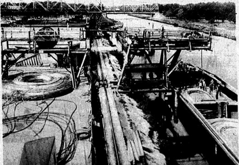
Von Warnemünde aus wurde ein neues Seekabel nach Dänemark verlegt. — Das deutsche Ende des Kabels wird bei Warnemünde auf einen Brahm übernommen Atlantic
