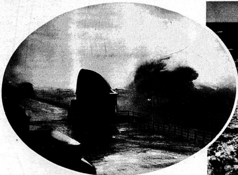
Eine Sturzwellen an der Strandmauer von Westerland auf Sylt bei Windstärke 12
