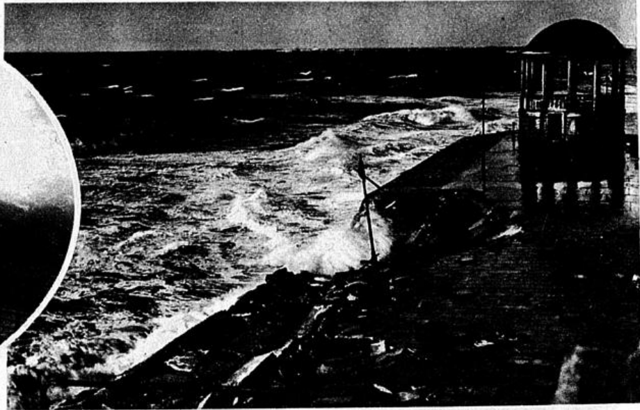
Auch auf Vorkum haben die Wassermassen ihr Zerstörungswerk getan
