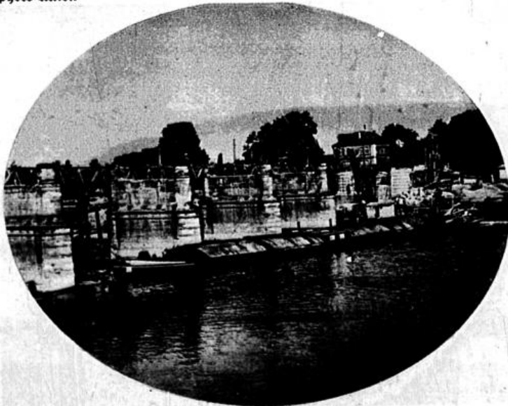
Die wegen ihrer engen Pfeileröffnungen von allen Schiffen seit langem gefürchtete Weserbrücke bei Rinteln wird jetzt endlich durch einen Neubau ersetzt. Das Bild zeigt den Abbruch der als „Engpäß“ bekannten Brücke mit den noch stehenden 4 Sandsteinpfeilern. Durch den auf dem Bilde sichtbaren, durch die Strömung vor die Brücke getriebenen Kahn (+), wurde die Schifffahrt kürzlich vorübergehend völlig gesperrt
