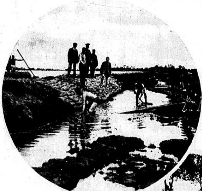
Im Kreis: Notstandsarbeiten der Reichswehr. Durch Heranschaffen von Sandfäden wird der bedrohte Damm gestützt Groß
