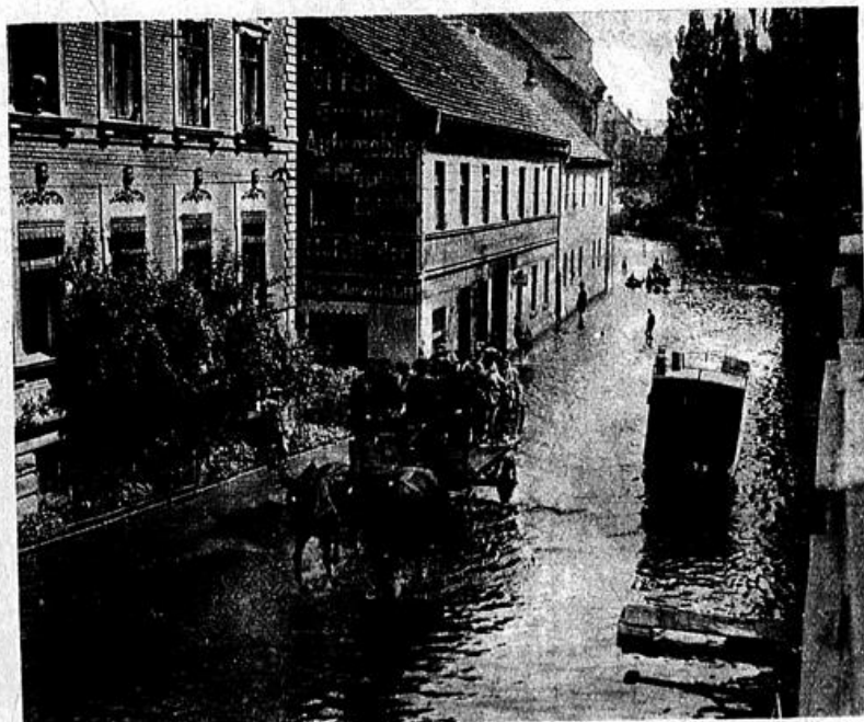
Auch in Guben an der Neiße ist das Wasser zum Verkehrshindernis geworden. Photothet
