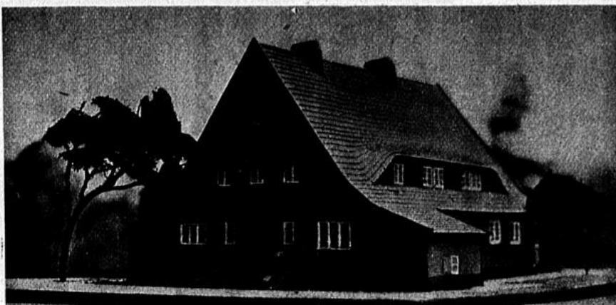
1. Modell des Kriegerwitwenheims in Deep an der Oßsee. Das Haus selbst ist erst im Rohbau fertig
