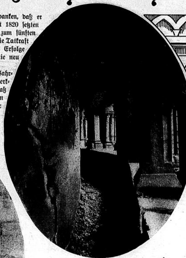
Der große Riß der Westwand, vom Innern der Säulengalerie gesehen.
