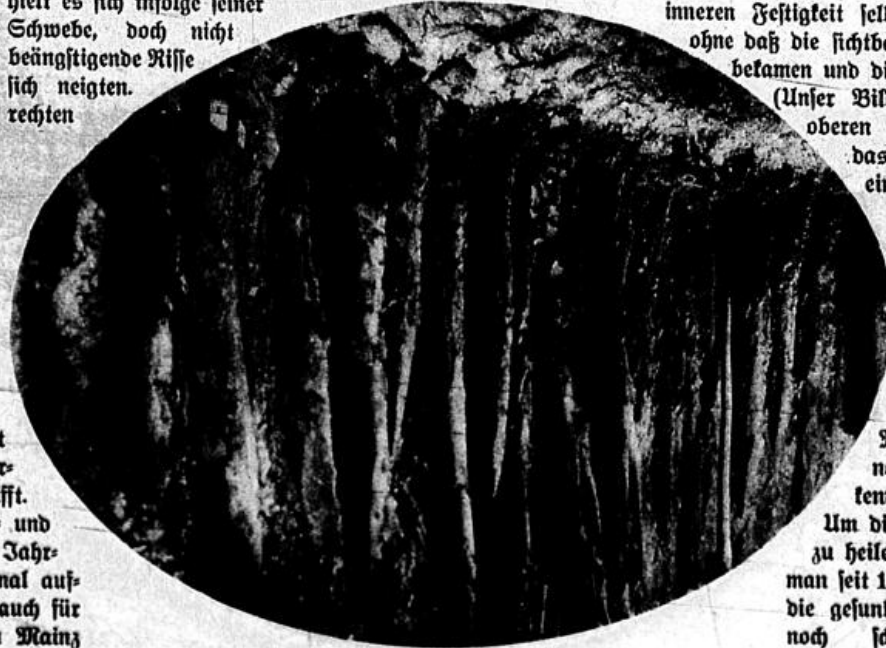
Pfahlwerk unter einer Pfeilervorlage des Mittelschiffes.
