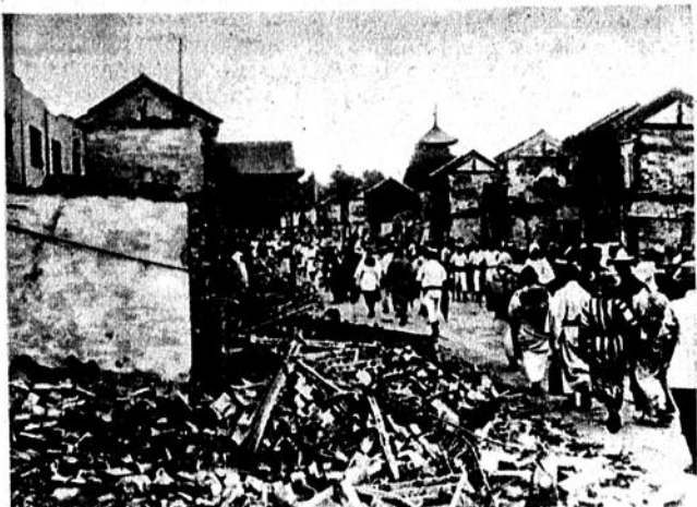
Zu dem Riesenbrand in Tokio Obdachlose in den verwüsteten Straßen suchen nach einer Unterkunft
