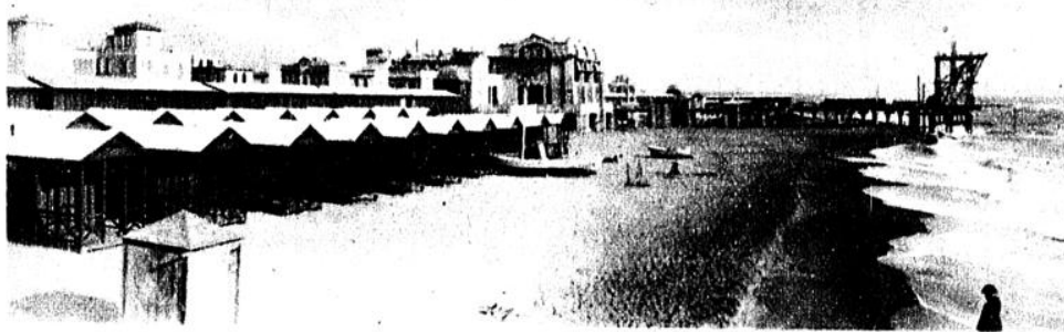
Die wundervolle neue Badeanlage von Ostia in Italien. Vom Kasino reicht ein Pfahlbau bis ins Meer.
