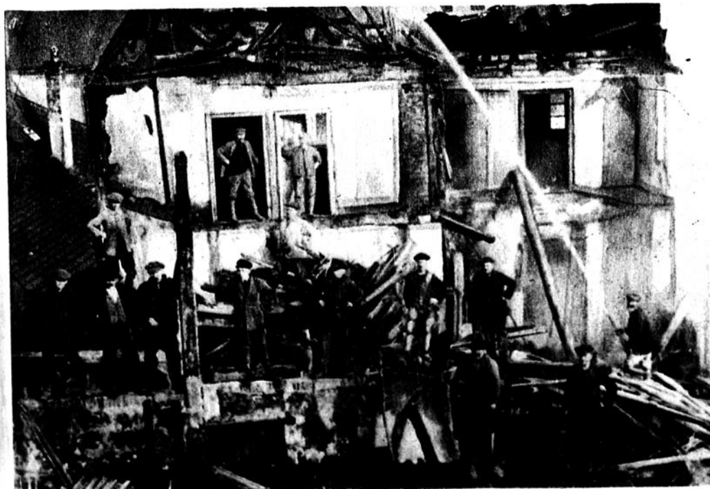
Der Riesenbrand der Pfeifen- und Zelluloidfabrik Müllenbach in Höhr (Westerwald); die Brandstätte
