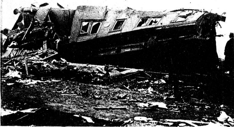
Die ungeheuerliche Wucht des Zusammenpralls zeigt uns dieses Bild in seiner grausigen Wirkung; zerknüllt und verbogen wie Pappe
