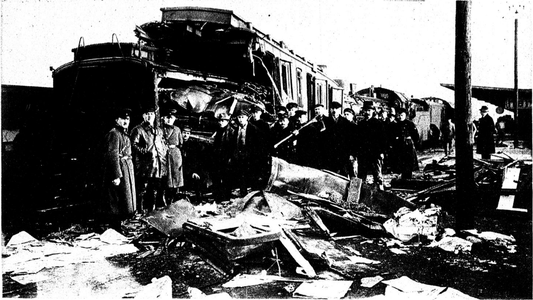
Die fürchterliche Trümmerstätte Das Bild zeigt sehr deutlich die ineinandergeschobenen Wagen, deren Insassen, etwa über 20, dem Tode nicht mehr zu entrinnen vermochten
