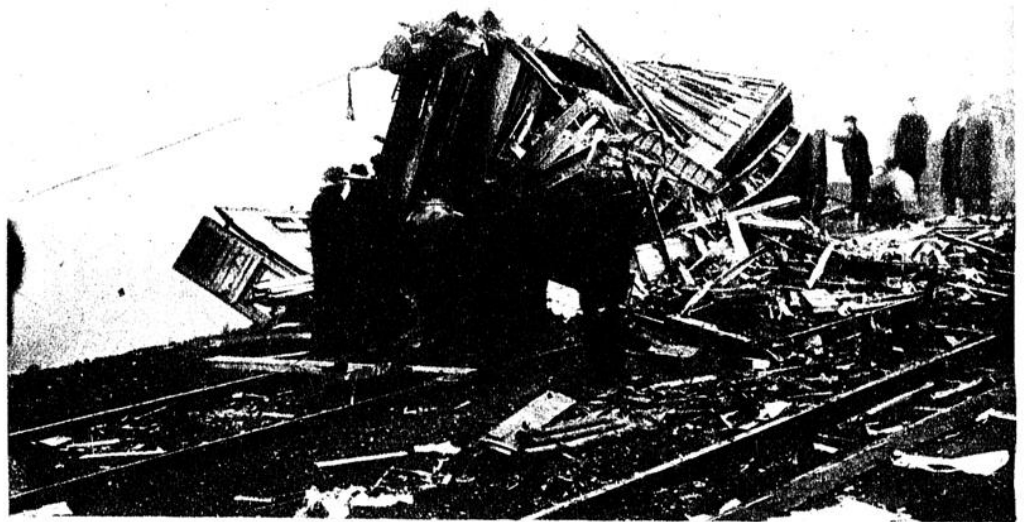
Die Aufräumarbeiten und das Freilegen des Geleises zeigt ebenfalls die ganze Katastrophe in ihrer Auswirkung!
