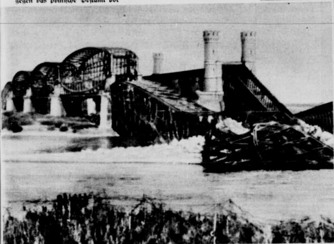
Polen sprengen die Eisenbahnbrücke von Dirschau Kurz vor ihrem Abzug verübten die Polen auf die bekannte Eisenbahn- brücke über die Weichsel in Dirschau einen Anschlag und sprengten die Brücke in die Luft
