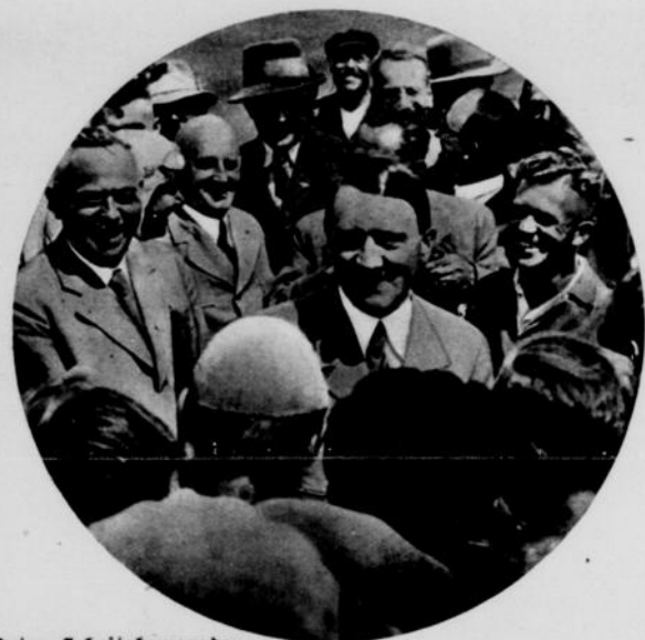
Unter Arbeitskameraden, die am Bau des Parteitaggeländes beteiligt sind, das demnächst einen würdigen Rahmen für die jährlichen Reichsparteitage ab- geben wird Aufn. Atlantic
