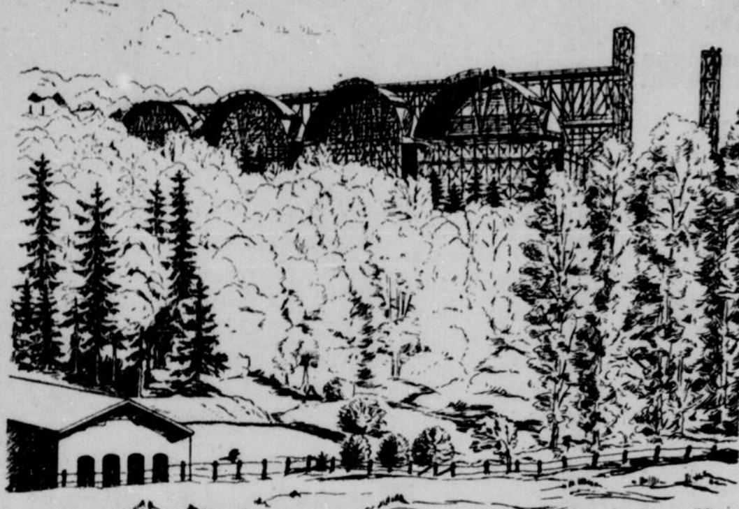
Hier entsteht die Reichsautobahnbrücke im Höllenbachtal
