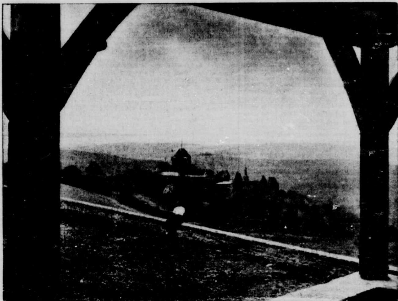
Schloß Burg vom Giebelportal der neuen Jugendherberge aus gesehen.
