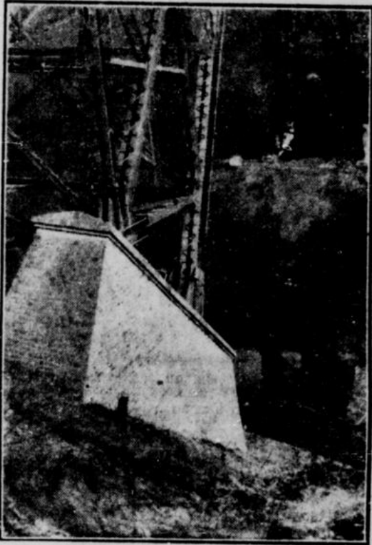
Im Vordergrund: Ein gewaltiges Bogenwiderlager auf der Solinger Seite. In der Ferne: die Bogenwiderlager auf der Remscheider Seite.
