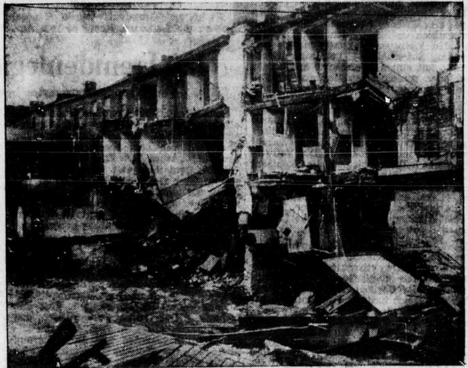
HAUSEINSTURZ DURCH ÜBERSCHWEMMUNGEN
