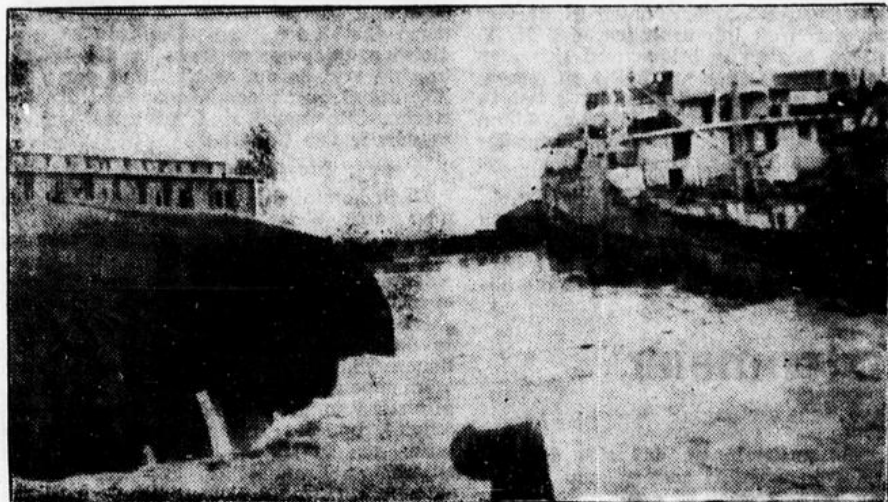
27 MILLIONEN MARK STURMSCHÄDEN IN GENUA
