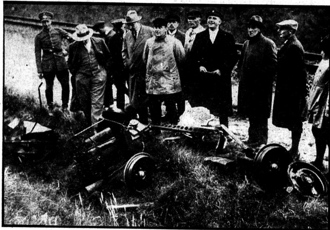
Auf der Strecke der Reichsbahn von Burgwedel nach Celle fanden am 4. August Versuche mit dem neuen Opel-Raketenwagen IV statt. Der Wagen flog, wie gemeldet, nachdem er eine Strecke von etwa 70 Metern durch die Luft und zerfiel vollständig. Ein Rad fand man 300 Meter von der Explosionsstelle entfernt im Walde.
