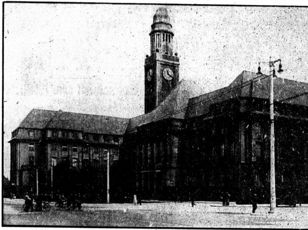
Das schöne Rathaus in Buer soll zu einem Taubenschlag werden. Es sollen 200 Tauben eingesetzt werden, die hoch oben im luftigen Turm ihren Schlag haben.
